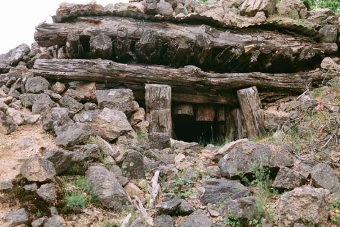
Λεπτομέρεια θυρίδας πολυβολείου και τμήμα πολυβολείου από κορμοξυλεία όπως αυτό υφίσταται σήμερα στην ορεινή περιοχή του Σκρα (Αρχείον ΕΕΕΣ Α.Ε. «Κηρύκειον»).
