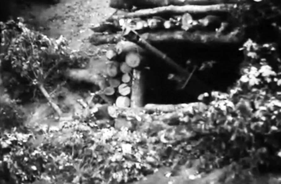
Πολυβολείο του ΔΣΕ, κατασκευασμένο από κορμούς δέντρων, στο Βίτσι.
