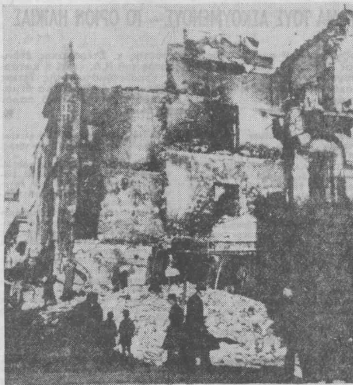
Οἱ κομμουνισταί, θέλοντας νὰ φτιάξουν ὁδοφράγματα κατὰ τὰς Δεκεμβερίαν, ἀνέντιναξαν ὁλόκληρα σπιτία, ὅπως αὐτὸ τῆς φωτογραφίας μας
